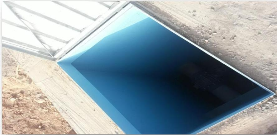
Figure 2: Regard de la vanne de sectionnement
