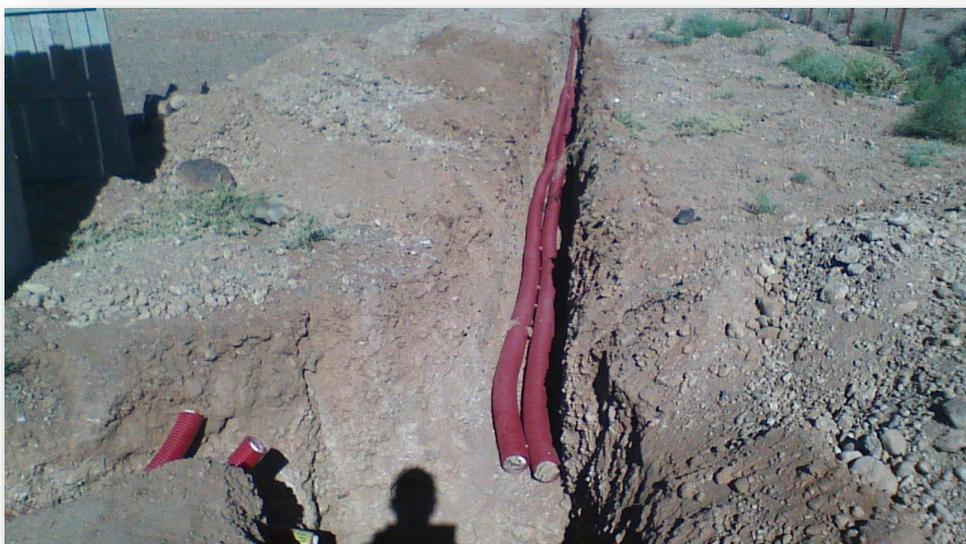
Figure 14: installation du tubage double paroi pour les câbles.
