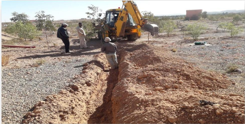
2 - Installation des tubages des câbles d'alimentation entre le local technique et le champ photovoltaïque
