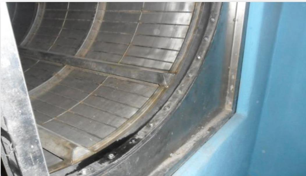
Figure6: La partie étanche du filtre qui sépare l'eau filtrée et celle chargée d'impuretés
