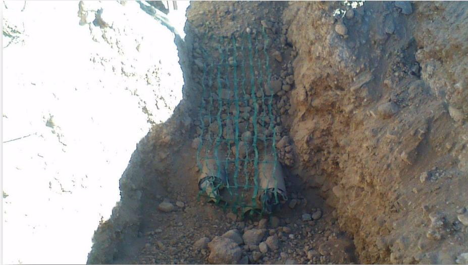
*Figure 15: Tuyaux de canalisation pour la protection des câbles.*
