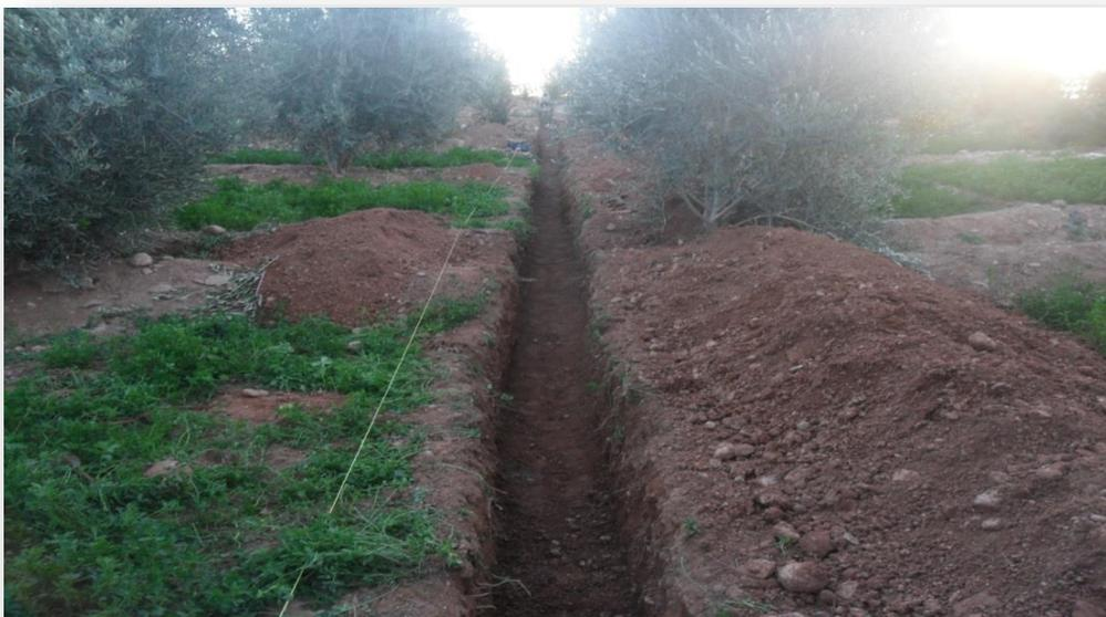
Figure 13: excavation du tranché entre le champ photovoltaïque et la station principale.
