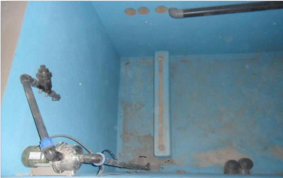
Figure 5: Canalisation de la pompe de rinçage et son filtre
