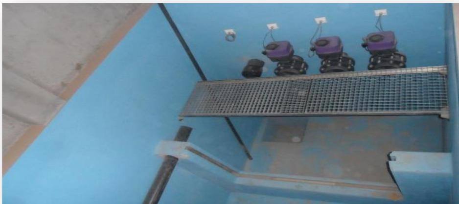
Figure 3: Peinture étanche et installation des électrovannes motorisées
